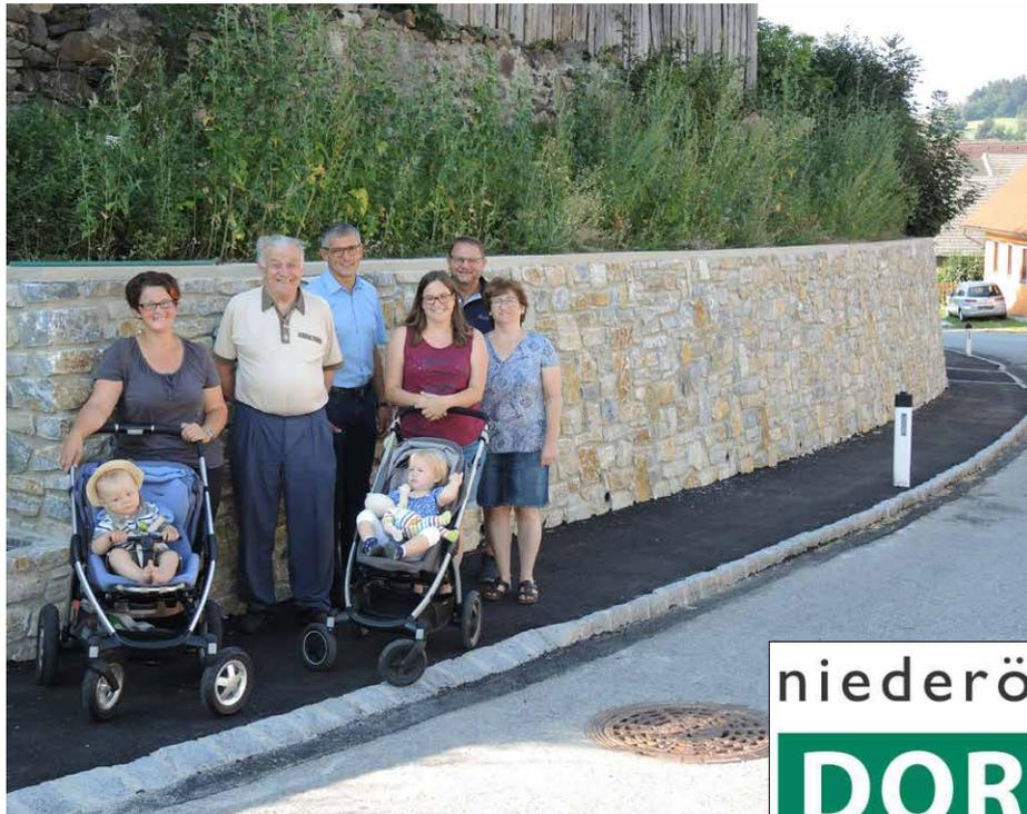
Entlang der Böschung wurde eine Steinmauer errichtet, um Platz für einen Gehsteig zu schaffen und das Ortsbild in diesem Bereich zu verschönern. Die dortige Wasserentnahmestelle konnte revitalisiert und gestalterisch in die Mauer integriert werden.
